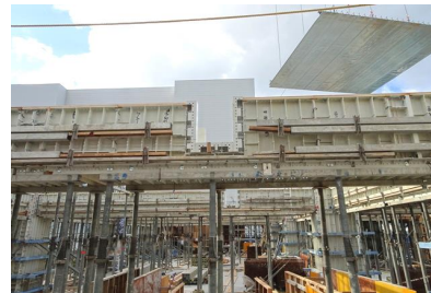
大梁の小梁接合部(デッキ敷き込み)
