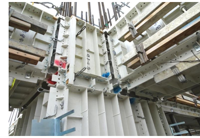
柱と梁の接合部
