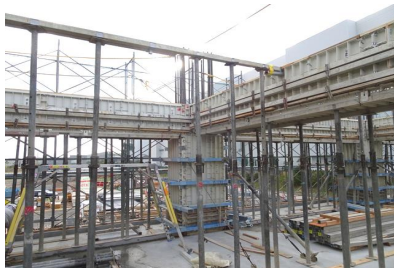
柱梁に「ガッチ」を使用
