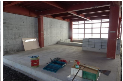
1Fの自転車置場と倉庫
