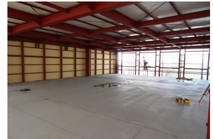
2F事務室(床コン打設)
