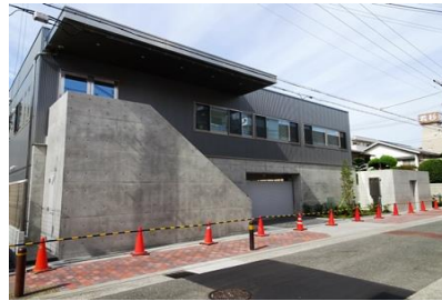
正面左側から
