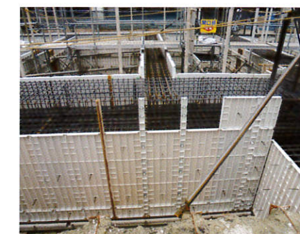
写真2: 現場への適用例 (大規模施設の基礎)
